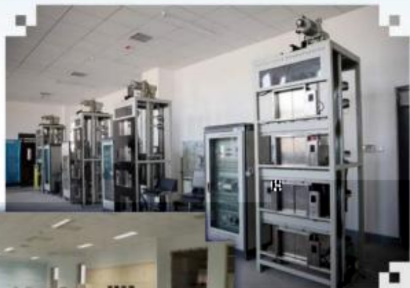
智能电梯安装调试 维护训练场所
